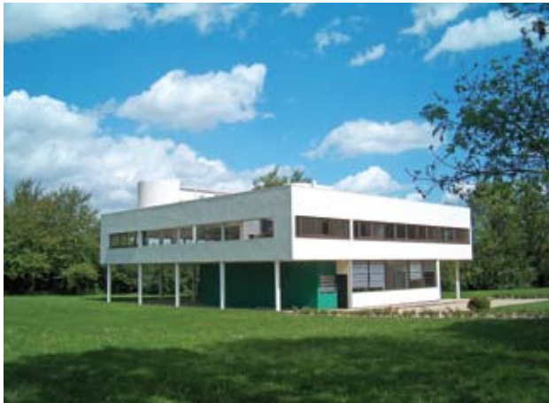
Le Corbusier – Vila Savoye 1929-1931, Poissy, Paris. Ilustrează cele cinci principii ale arhitecturii moderne: planul liber, parterul pe piloți, acoperișul terasă, fațada liberă, ferestre continue / Le Corbusier – The Savoye Villa, 1929-1931, Poissy, Paris. This building illustrates the five principles of modern architecture: free plan, posts supporting the ground floor, clear façade, strip windows
